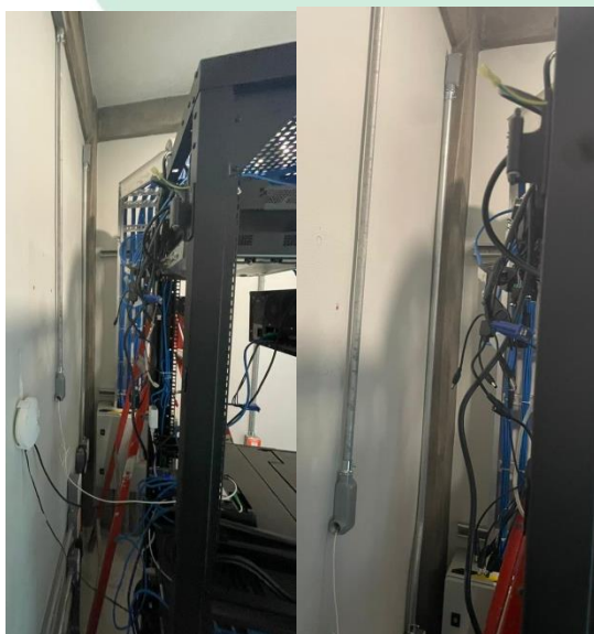
Imagen 6. Previo al Mantenimiento
