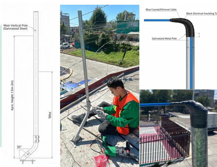
Imagen 3. Diagrama de instalación de la mufa
