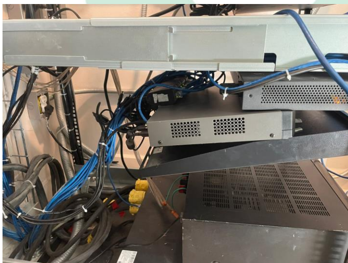
Imagen 10. Previo al Mantenimiento
