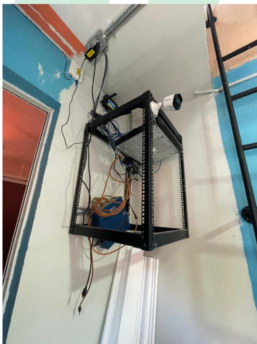
Imagen 8. Previo al Mantenimiento
